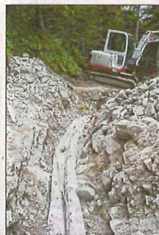
Die Abwässer können jetzt ins Tal abgeleitet werden.
