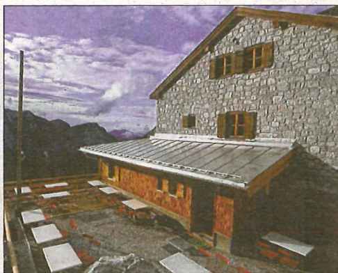
Der neue Anbau inklusive neuer Terrasse.
